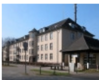
Umgebautes Mannschaftsgebäude, Zeilenbau A, Oxforder Straße
